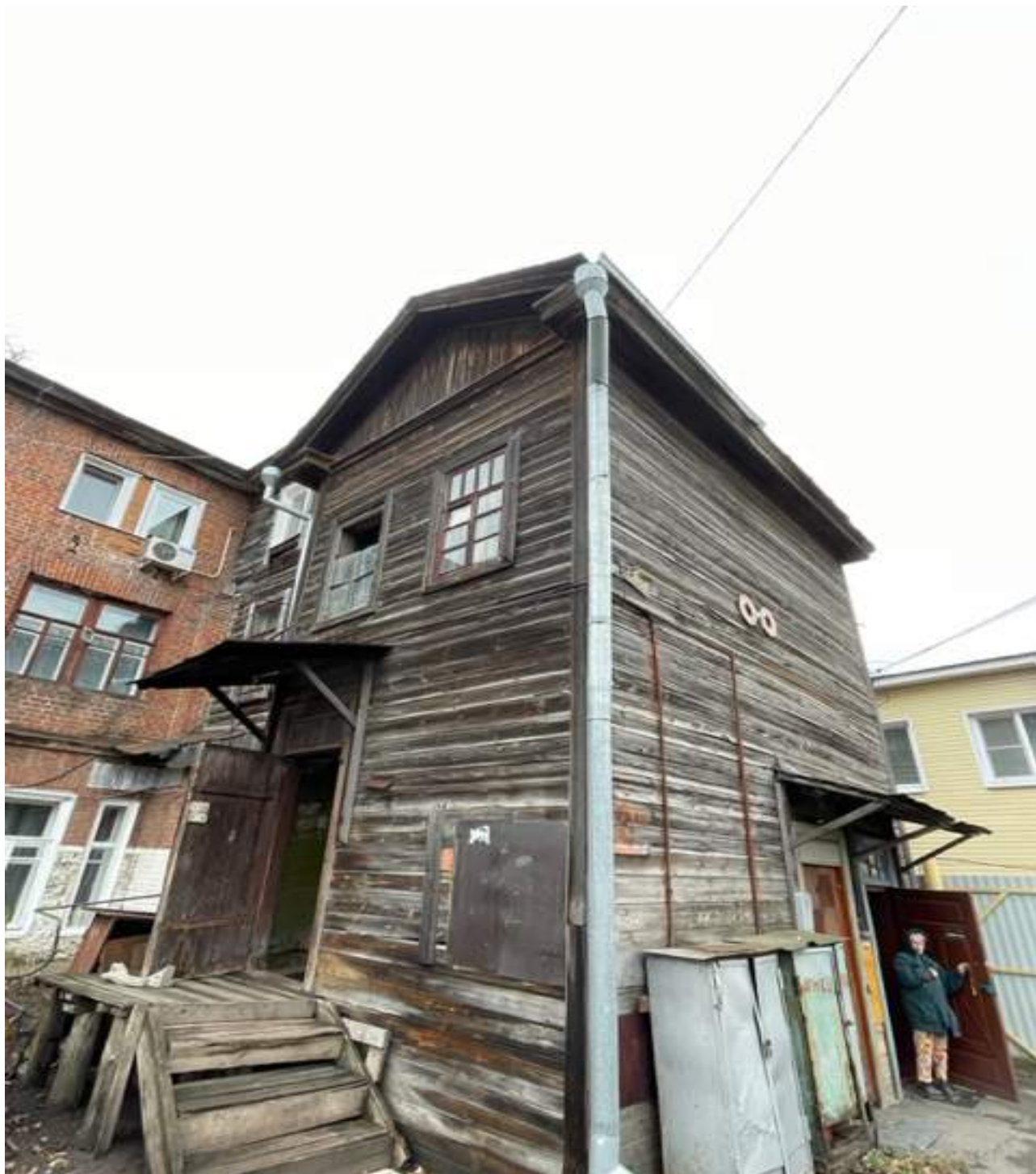
Фото № 14. Прямоугольная форма двух оконных проемов второго этажа восточного фасада деревянной двухэтажной части дворового объема с простым рамочным обрамлением и многочастным рисунком остекления.
