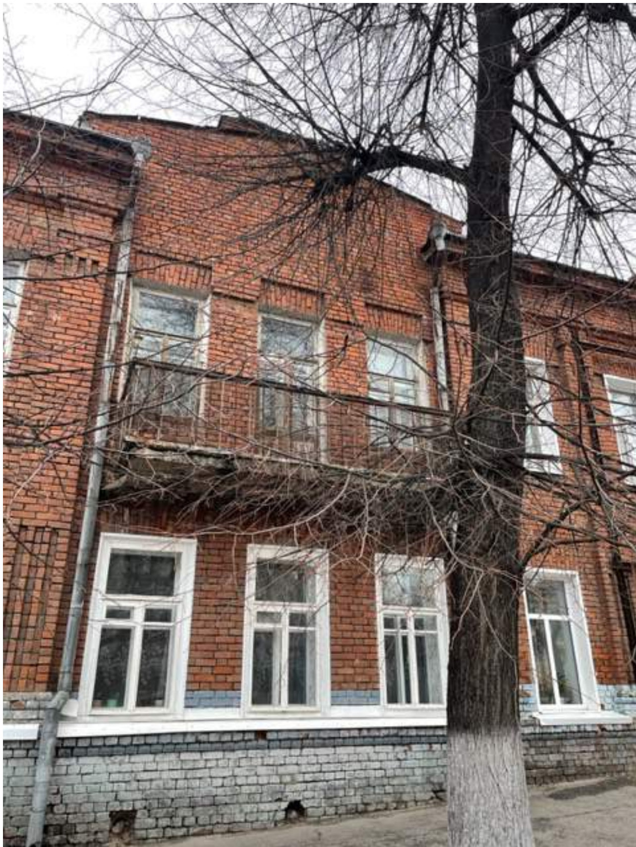
Рис. 3. Вид на южный фасад здания при движении с запада на восток по улице Ленина
