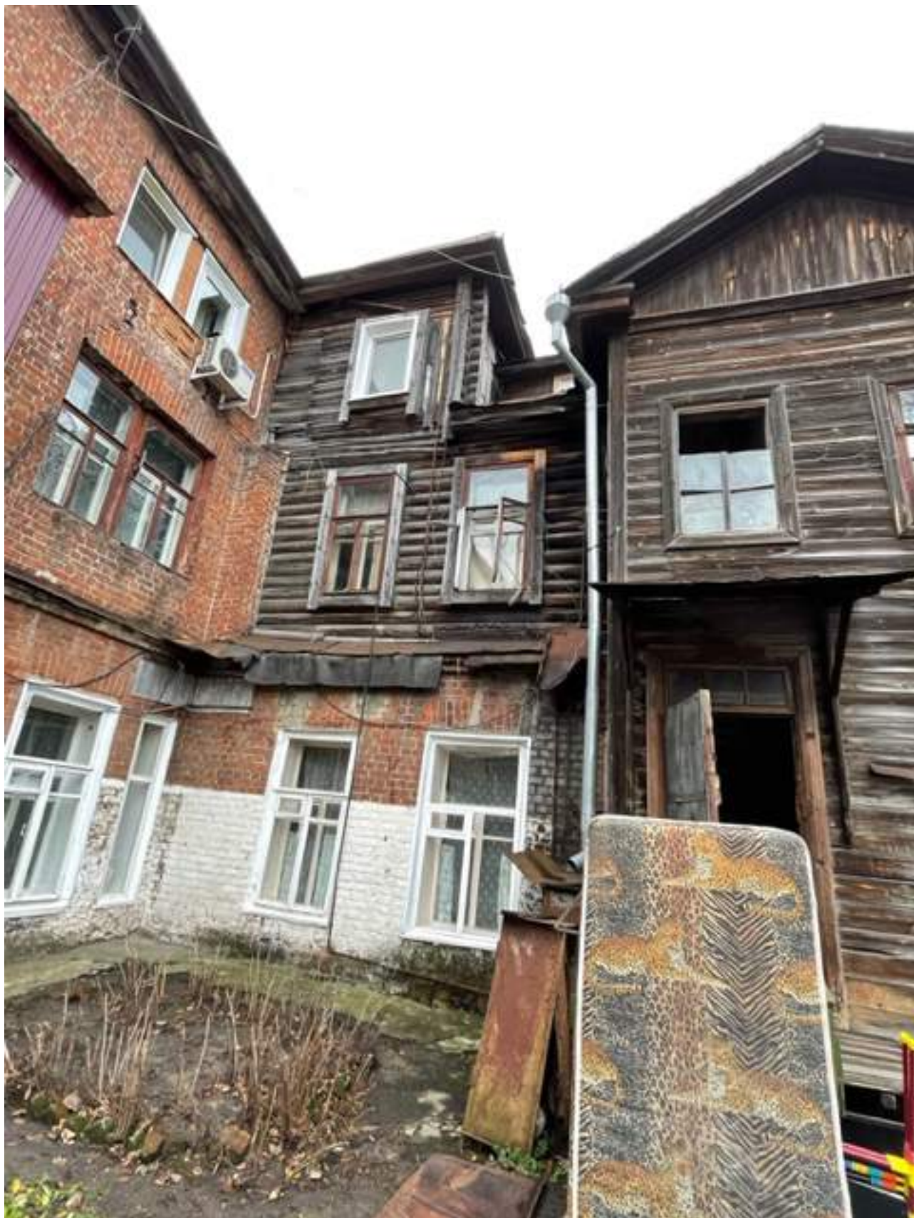
Фото № 15. Окна второго и антресольного этажей дворовой части прямоугольной формы с простым рамочным обрамлением
