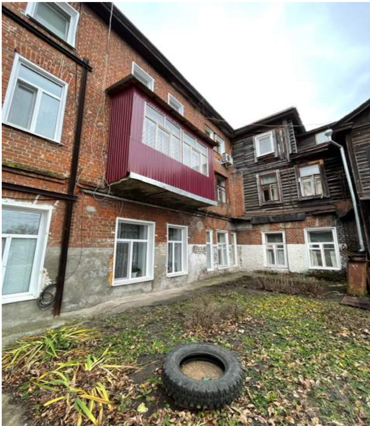
Фото № 10. Межэтажный карниз северного фасада.
